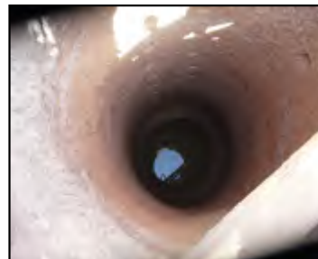
Enfin, l'eau affleure à près de 8 m. de profondeur
