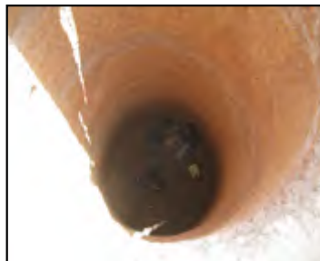
Les ouvriers sont au fond, à env. 6 m.
